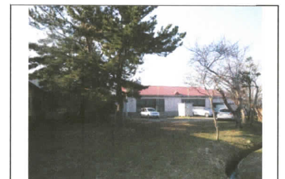
⑧から撮影した写真
