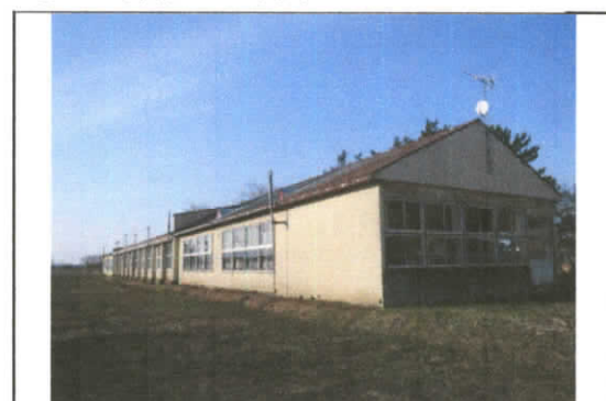
⑪から撮影した写真
