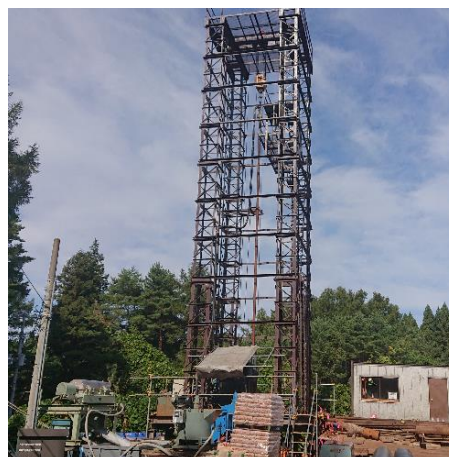
天田内取水井更新事業
