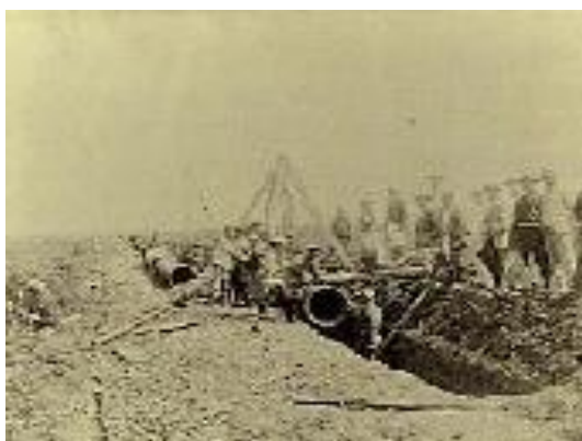
創設時の配水管の布設
