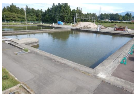
北系ろ過池（左端1号池、中央2号池）
