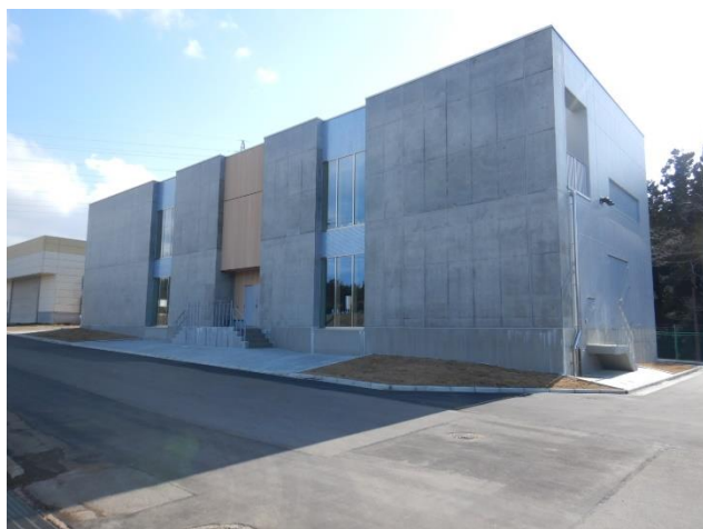
横内浄水場 紫外線・塩素処理棟
