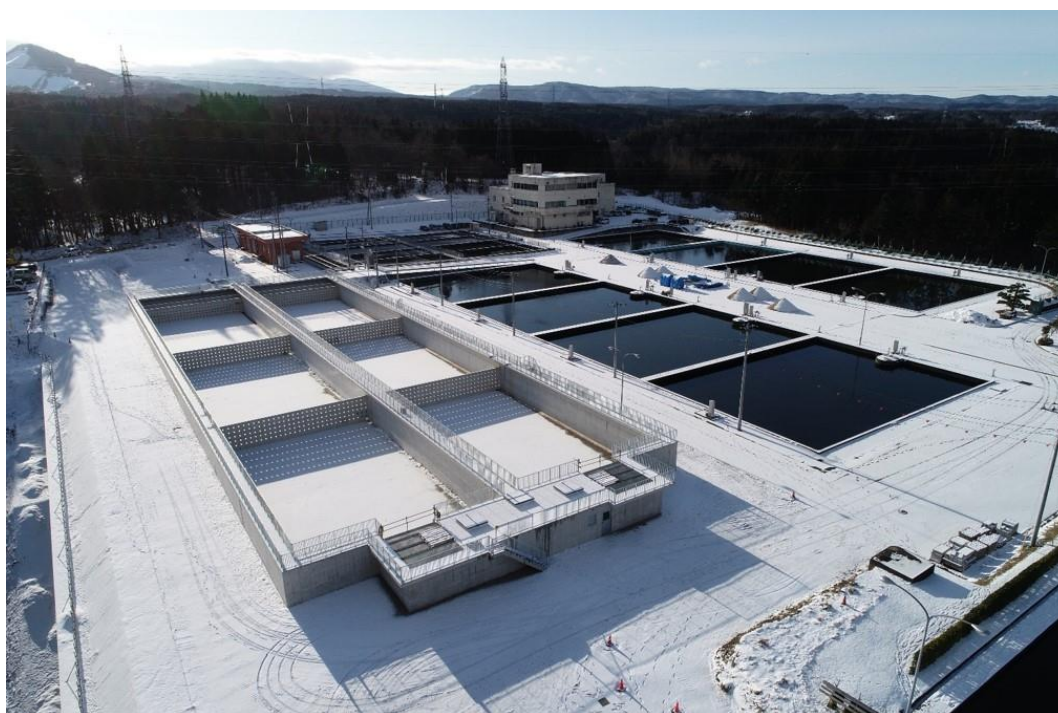
横内浄水場 新北系沈殿池（写真中央左側部分）
