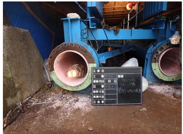
水管橋の更生工事
