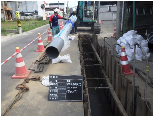
管路の耐震化工事
