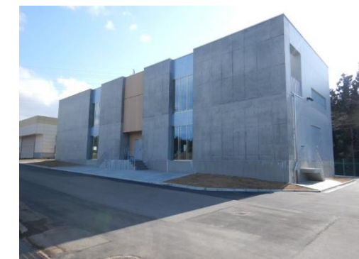
横内浄水場紫外線処理施設の導入（R3年度）
