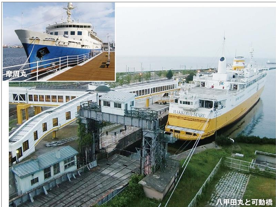
図 参考 45 青函連絡船及び可動橋
