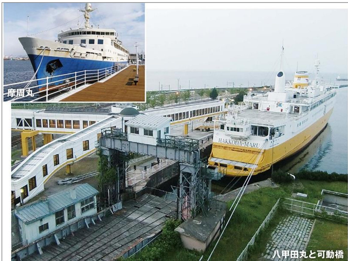
図 参考 45 青函連絡船及び可動橋
