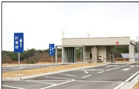
施設に運ばれてくるごみの重量を計量します。
