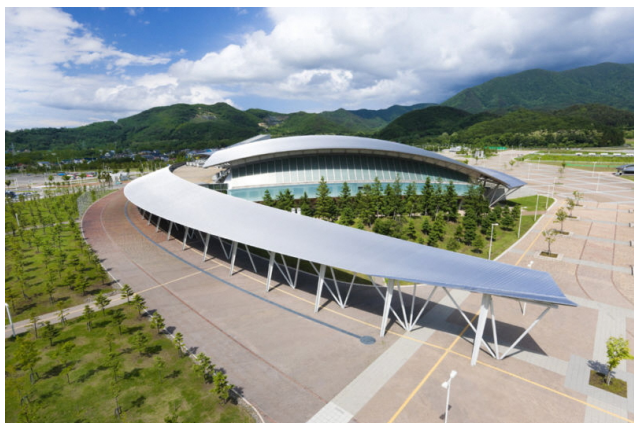
出町さんが防水施工を行った 新青森県総合運動公園 マエダアリーナ
