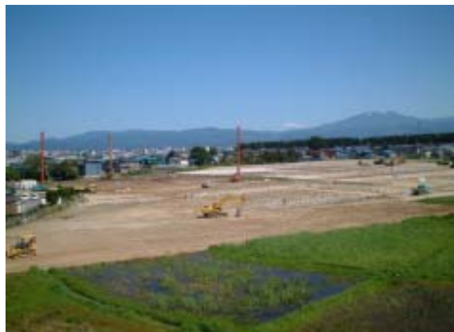
造成地全景 八甲田山を望む
