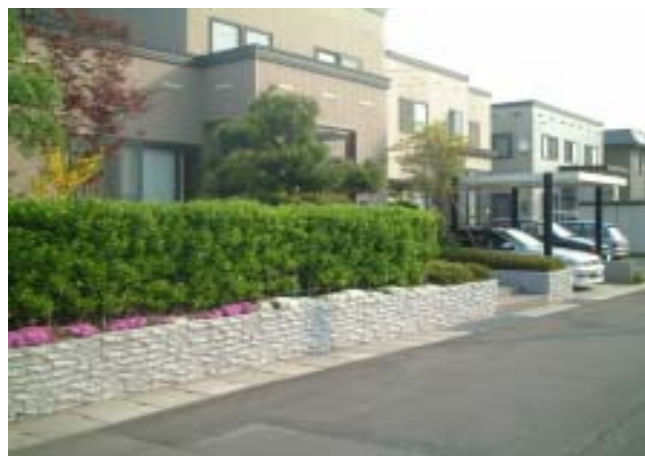
高さ約 50cm 程の土留めは化粧コンクリート仕上げ、生垣の根元には白とピンクの芝桜を配し、美しく演出している例
