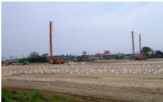
軟弱地盤対策工事 ペーパードレーンの打設
