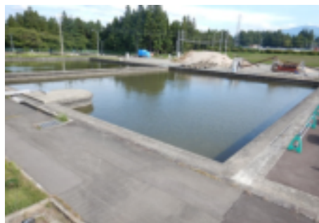
北系ろ過池（左端1号池、中央2号池）
