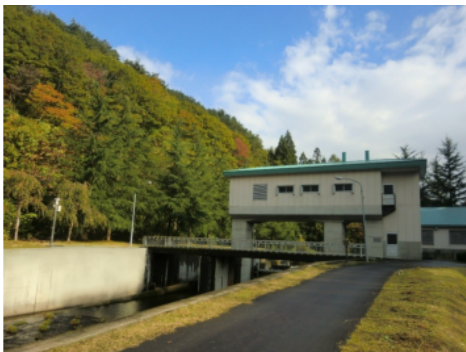
横内浄水場水源地 (取水施設)
