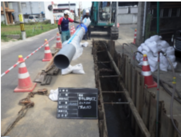
管路の耐震化工事
