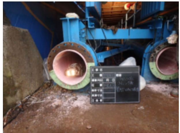
水管橋の更生工事
