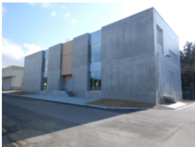
横内浄水場 紫外線・塩素処理棟
