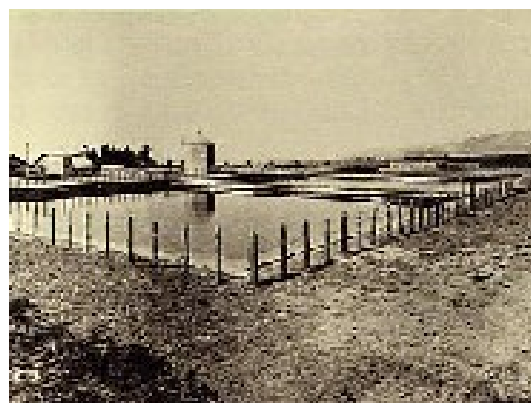
大正時代の横内浄水場
