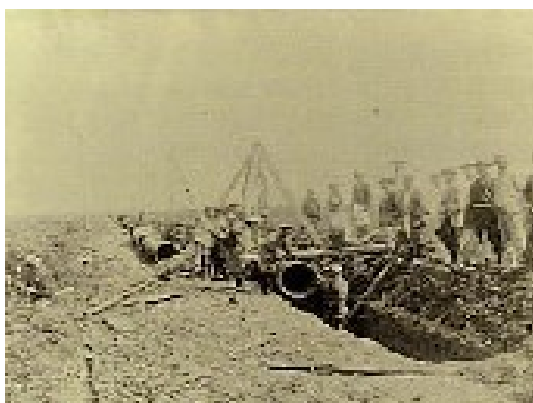
創設時の配水管の布設
