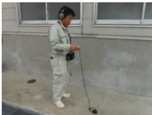
漏水探知機による漏水調査
