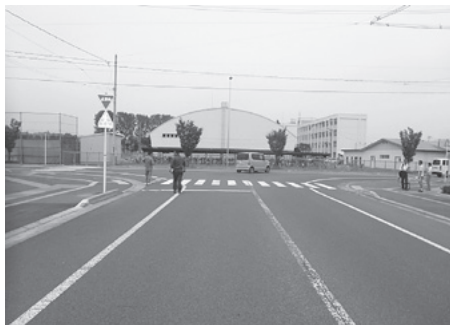
〈信号機の設置が要望されている、ユニバース大野店から青森南高等学校にぶつかる丁字路の様子〉
