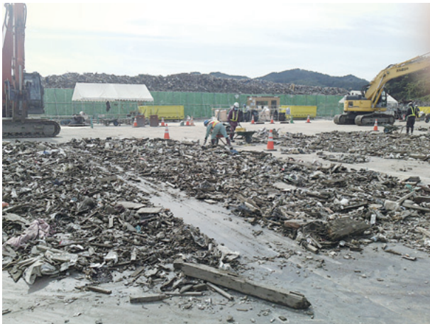
〈震災瓦れき処理の様子（10月、岩手県宮古市にて撮影）〉
