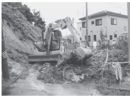
〈市道に堆積した土砂の除去作業の様子〉
