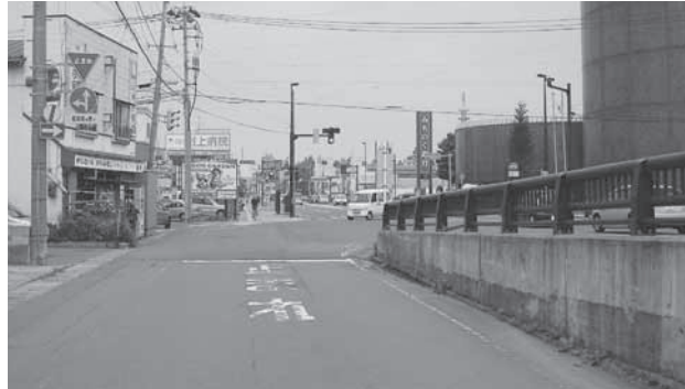
〈側道用信号機の設置などの対策が求められている八甲田大橋北側の交差点付近〉
