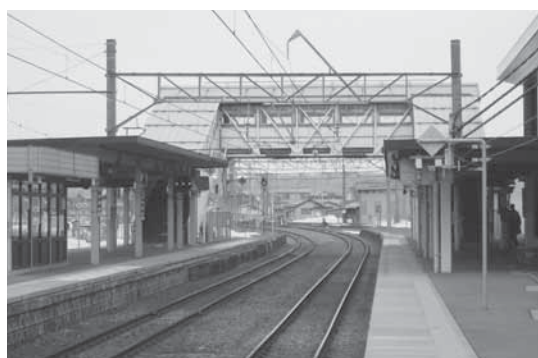
〈バリアフリー化を求める声が寄せられている浪岡駅ホーム〉
