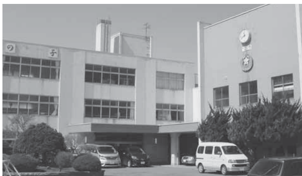
〈平成24年度に改築工事に着手する予定の金沢小学校〉
