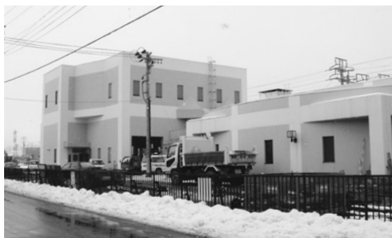
〈平成20年度の完成に向けて工事が進む奥野第三ポンプ場〉
