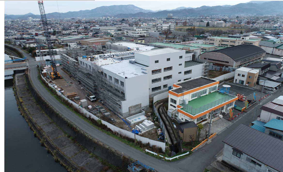
工事状況 (令和4年11月30日撮影)
