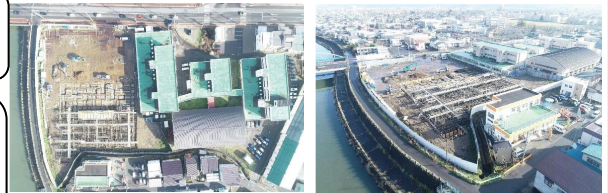
●工事状況(令和3年11月30日撮影)
