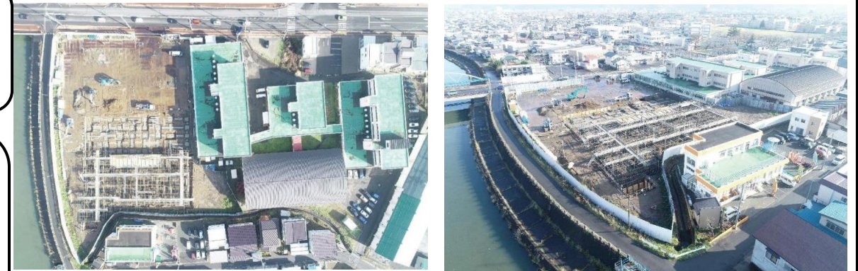
●工事状況（令和3年11月30日撮影）
