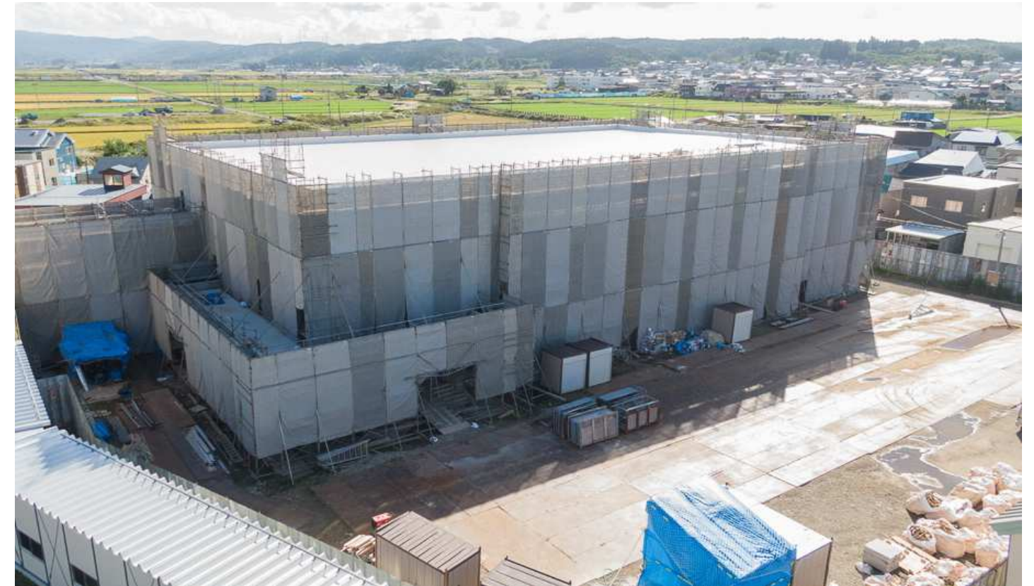
工事状況 (令和5年9月29日撮影)
