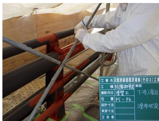
塗替塗装工例
