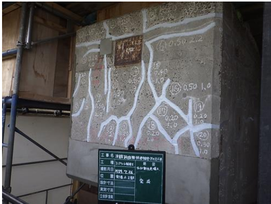
ひびわれ補修工例
