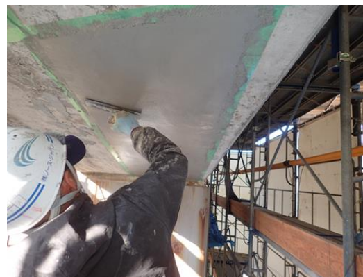
断面修復工例
