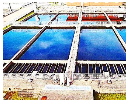
横内浄水場の沈殿池
