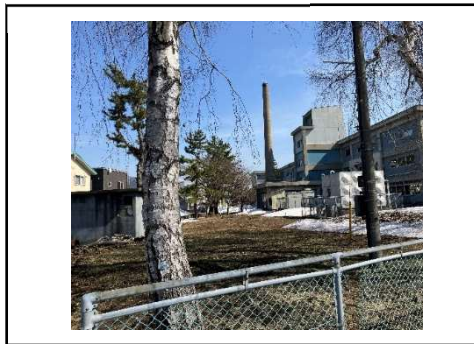
⑪から撮影した写真
