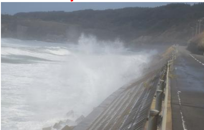
※高波による交通障害写真
