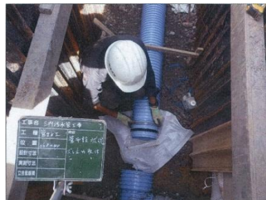
管路新設工事
