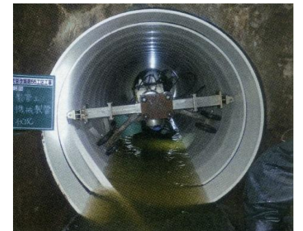
管渠改築工事
