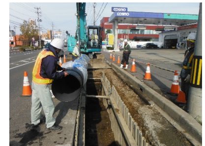
配水管（φ500 ミリ）の更新工事
