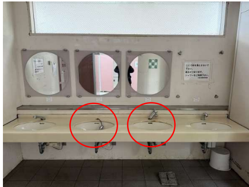
女子トイレ破損状況（水道蛇口）
