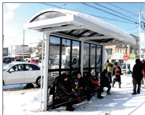
待合所の新設
