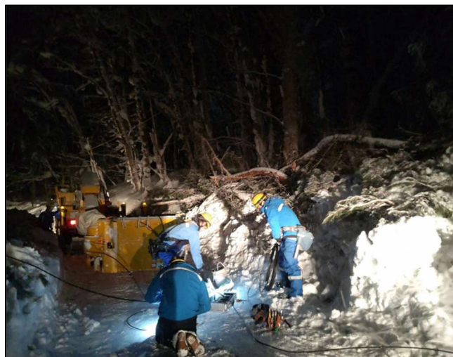
高圧線への倒木除去（R7）
