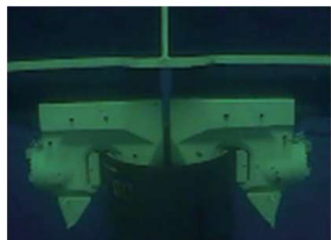
施工実証実験の事例
