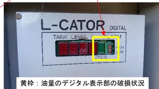
地下タンク油量計 (内部)
