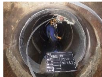
管更生施工イメージ
