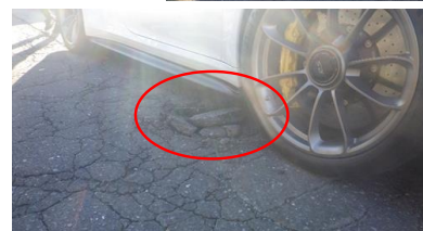
タイヤが舗装片に上 がり、跳ね上がったこ とによる車両の損傷
