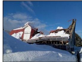
屋根雪により全壊した牛舎
