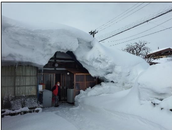
豪雪によりせり出した屋根雪
