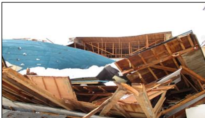
屋根雪により全壊した浪岡中央児童館
