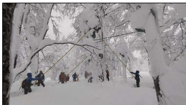
配電線の冠雪除去（R7）
