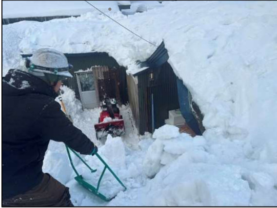
災害救助による屋根雪下ろし (R6)
