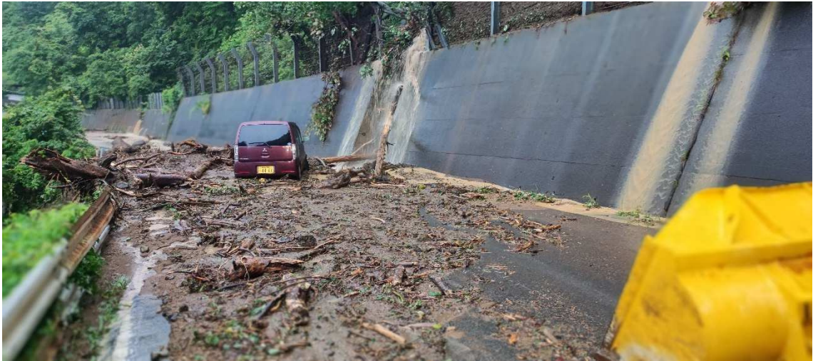
※令和4年度 8月大雨被害
