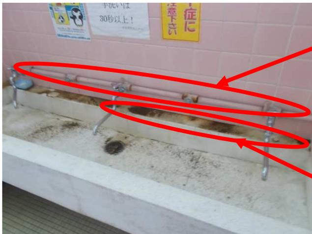
壁面のネジ穴等より漏水
