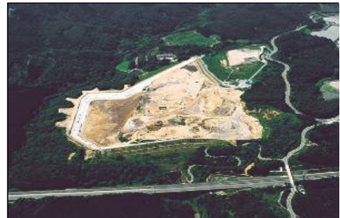
青森市一般廃棄物最終処分場
