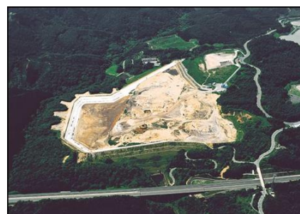
青森市一般廃棄物最終処分場
