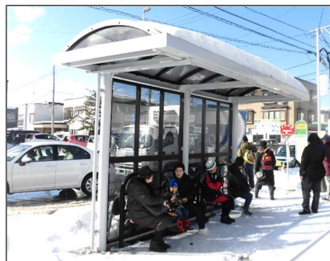
待合所の新設
