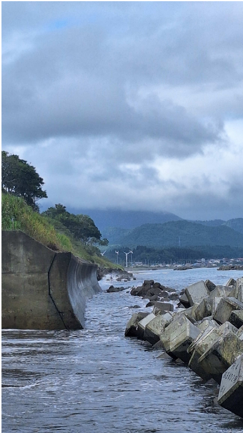
【既設消波ブロック水没】
