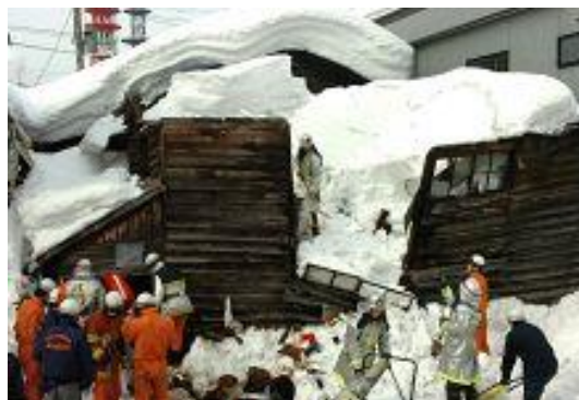
図 54 雪の重みで倒壊した家屋
