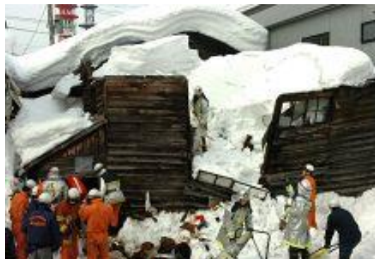
図 81 雪の重みで倒壊した家屋
