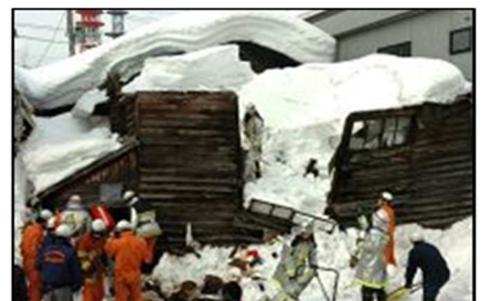
【雪の重みで倒壊した家屋】
