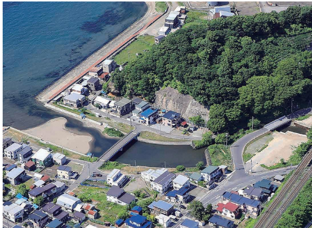
(河川改修中の貴船川)
