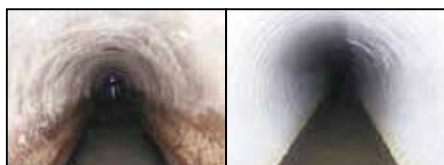
管更生の施工前(左)と後(右)
