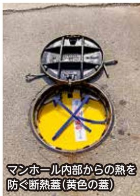
マンホール内部からの熱を防ぐ断熱蓋(黄色の蓋)
