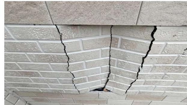
(幅約30cm、高さ約45cmの凹損)
