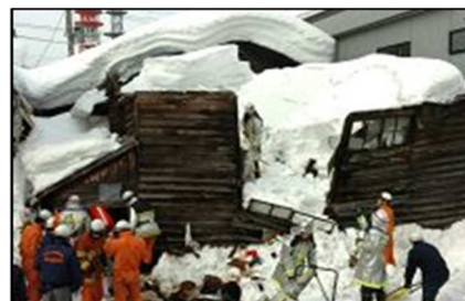
【雪の重みで倒壊した家屋】
