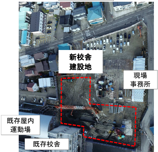
工事状況(令和6年11月25日撮影)
