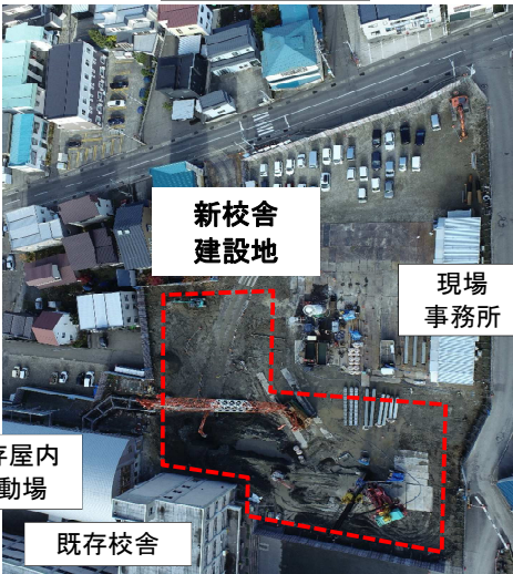
工事状況 (令和6年11月25日撮影)
