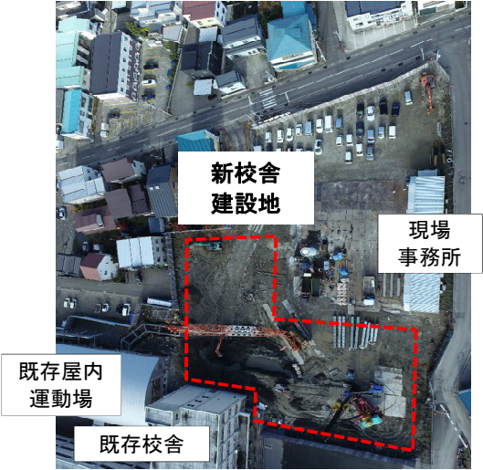
工事状況（令和6年11月25日撮影）
