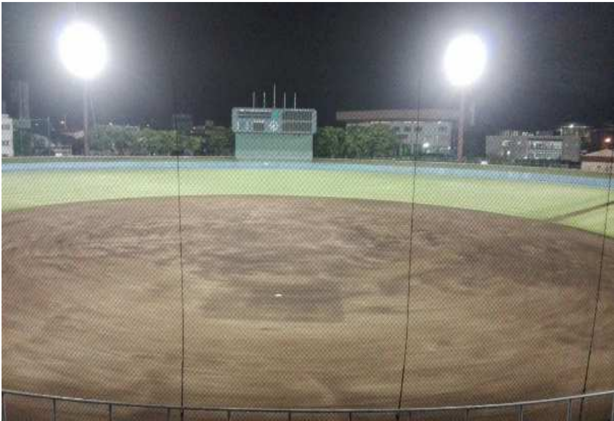
＜夜間照明改修＞ ■現況の水銀灯からLED照明に更新
