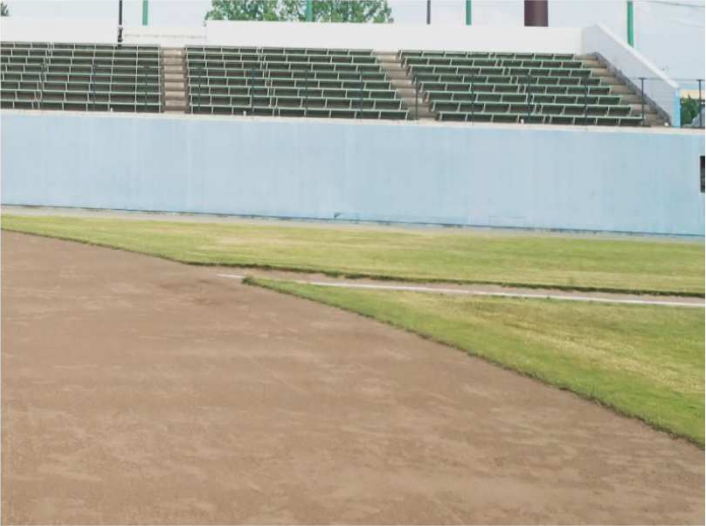
＜グラウンドの改修＞ ■内野（土）と外野（天然芝）の段差解消
