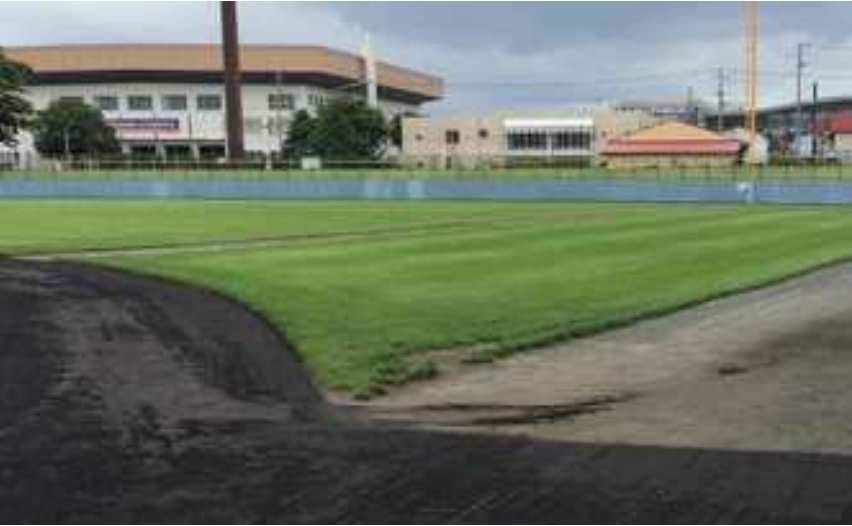
＜グラウンドの改修＞ ■内野（土）と外野（天然芝）の段差解消
