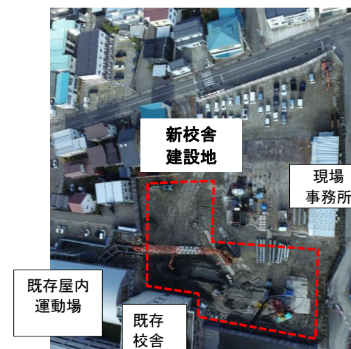
工事状況（令和6年11月25日撮影）
