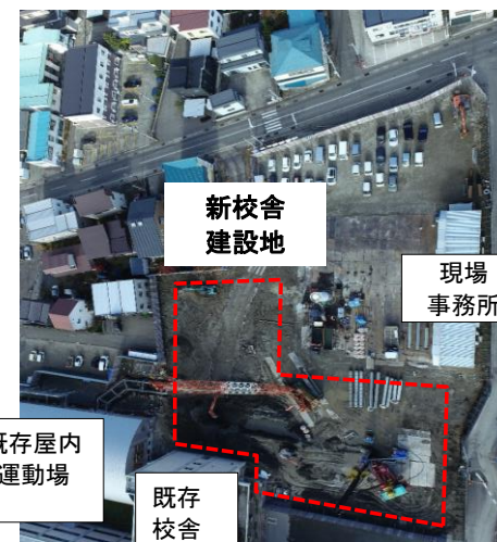
工事状況(令和6年11月25日撮影)
